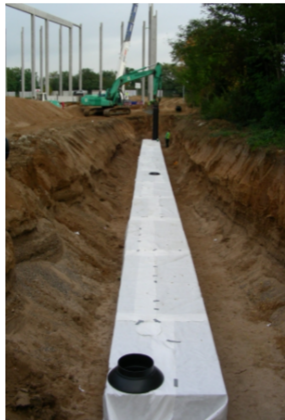
Bau einer Rigole zum Niederschlagsmanagement. Foto: Schukat electronic Vertriebs GmbH
